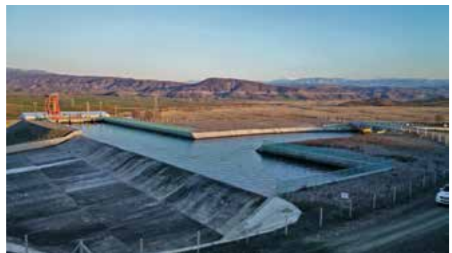
Wasserschloss mit Streichwehr und Turbineneinlauf
