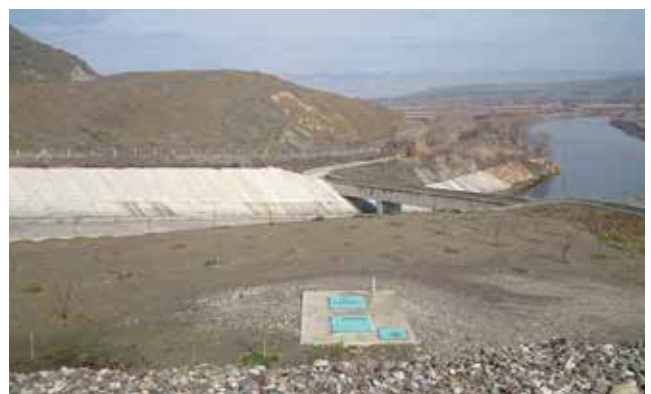
Streichwehrüberlauf und Unterwasser des Kizilirmak
