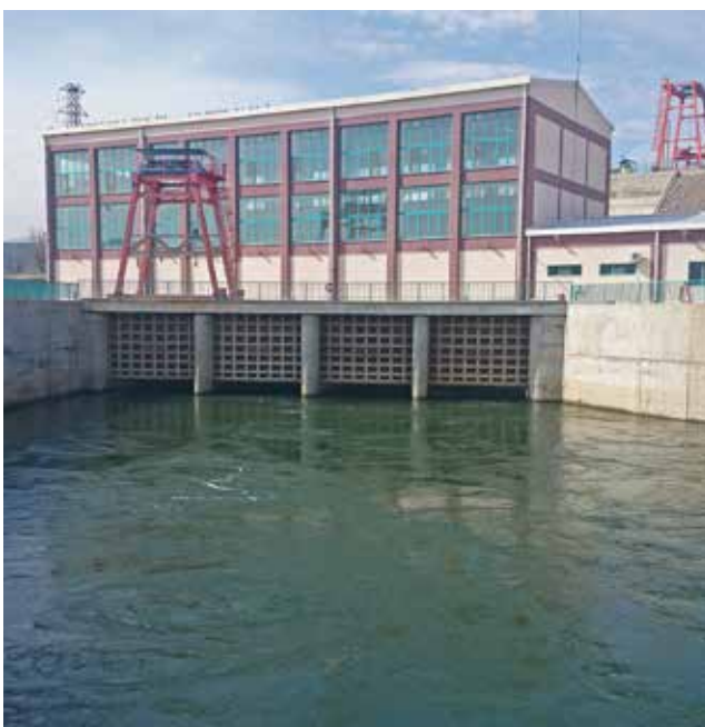
Krafthaus mit Turbinenausläufen
