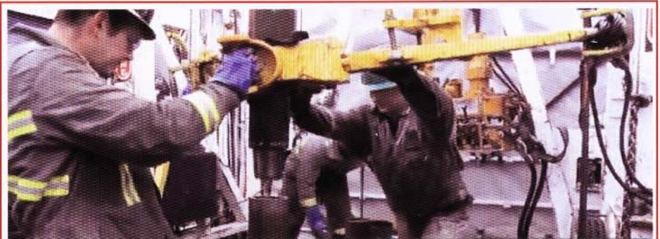
Bohrkopfwechsel im Fördergebiet Joffre. Ausschnitt aus dem Informationsvideo https://www.youtube.com/watch?v=CbB4gyesT_Y , "Joffre D2 Pool" vom 07.03.2013. Das operative Management erläutert vor Ort das Potenzial des Fördergebiets im westkanadischen Becken in Zentral-Alberta mit einer Ausdehnung von ca. 70 km 2 .
