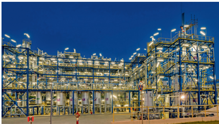
Lichtblick Chloressigsäure-Anlage von PCC in Polen
