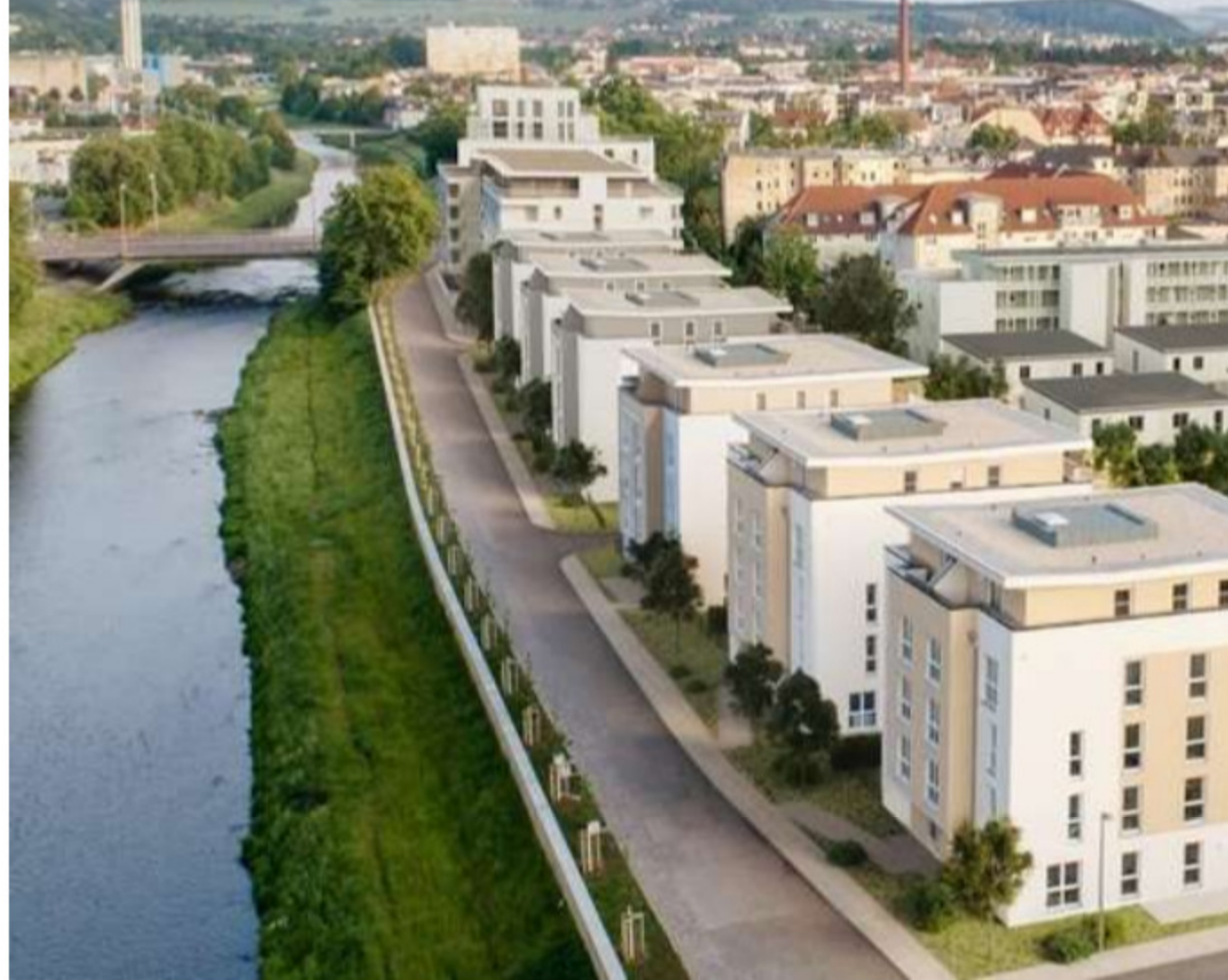
Referenzobjekt HeinrichsQuartier in Gera, 220 Wohneinheiten
