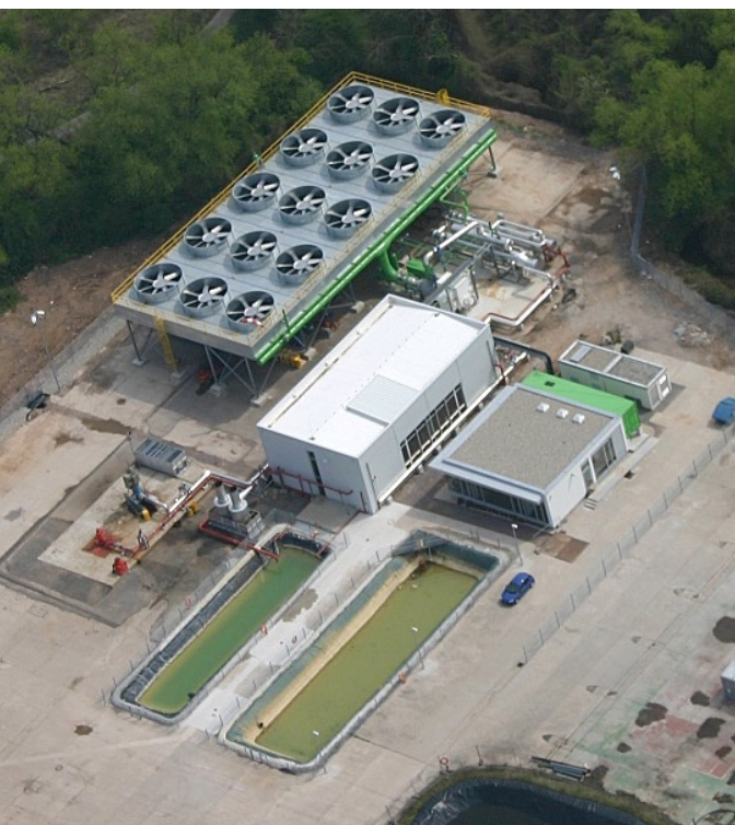
Geothermiekraftwerk in Landau © www.geox-gmbh.de
